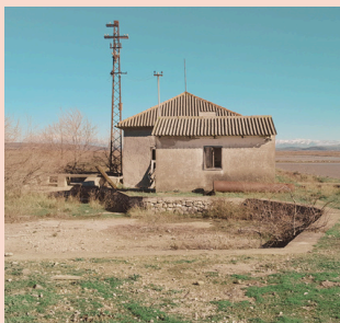
Pumpna stanica: PS 9
