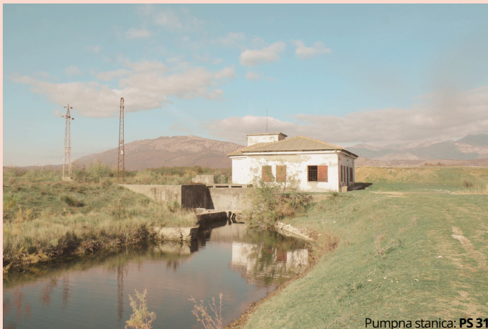
Pumpna stanica: PS 31
