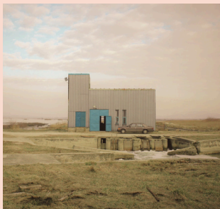
Pumpna stanica: PS 16
