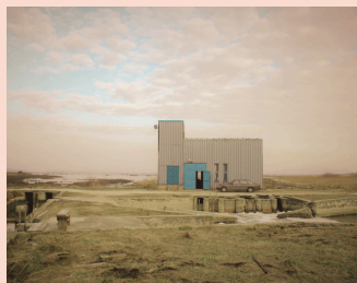
Stacioni i pompës: SP 16
