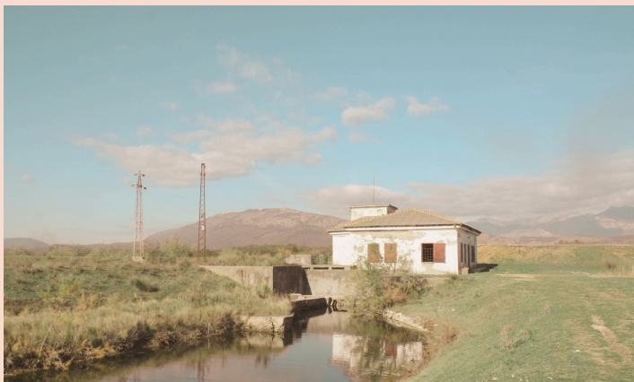
Stacioni i pompës: SP 31
