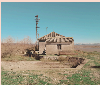
Stacioni i pompës: SP 9
