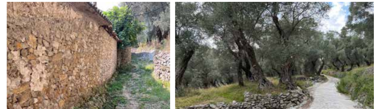
Dio kaldrmisaniog puta iza kuća Nove Mahale; Dio puta koji je betoniran
