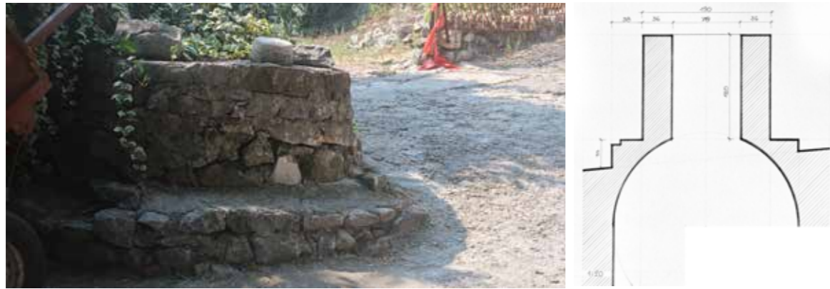
Fotografija i presjek kroz bunar
