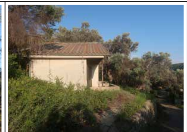
Napuštene montažne kuće za smještaj u okviru maslinjaka
