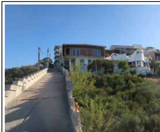
Izgradnja u jugozapadnom dijelu obale
