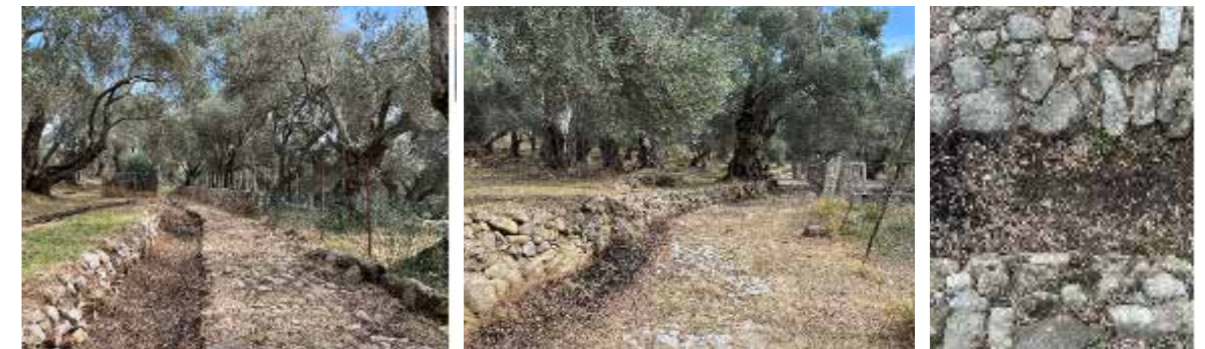
Fotografije staze sa kaldrmom i kanalom; detalj kaldrme i kanala
