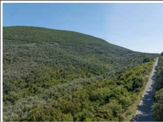
Pogled na gornji dio udoline i novi asfalni put
