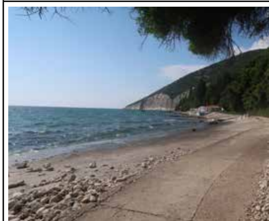
Betonska staza i plažni objekti
