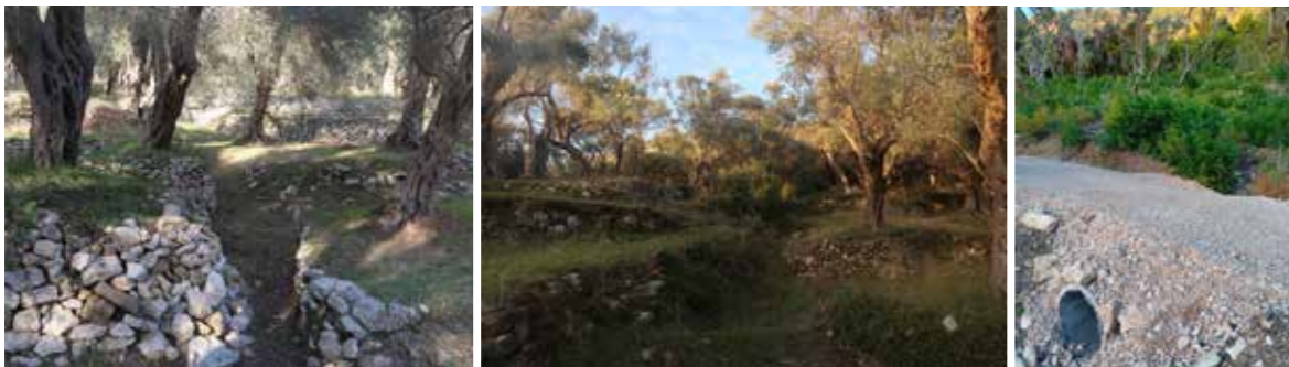
Održavane poprečne staze; Zarasle staze i kanali; Postavljanje betonskih cijevi ispod novih puteva
