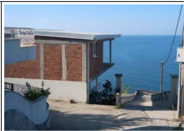
Izgradnja u jugozapadnom dijelu obale
