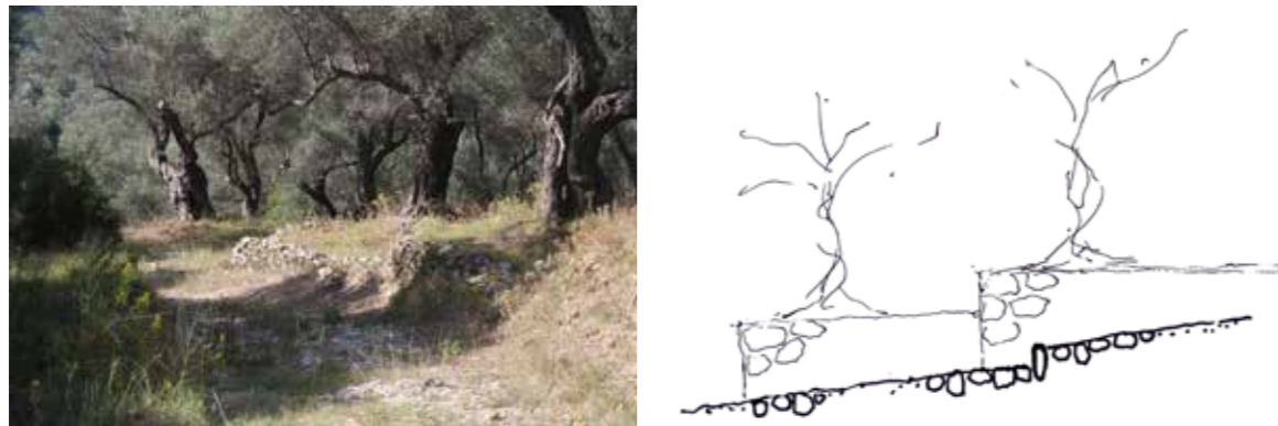
Fotografia dhe skica e prerjes tërthorë të rrugës me mbetjet e kalldrëmit me shkallë të ulta
