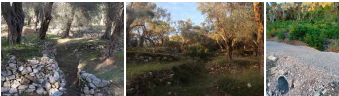
Rrugët dytësore të mirëmbajtura; Shtigjet dhe kanalet të mbuluar me bimësi; Vendosja e tubave të betonit nën rrugë të reja
