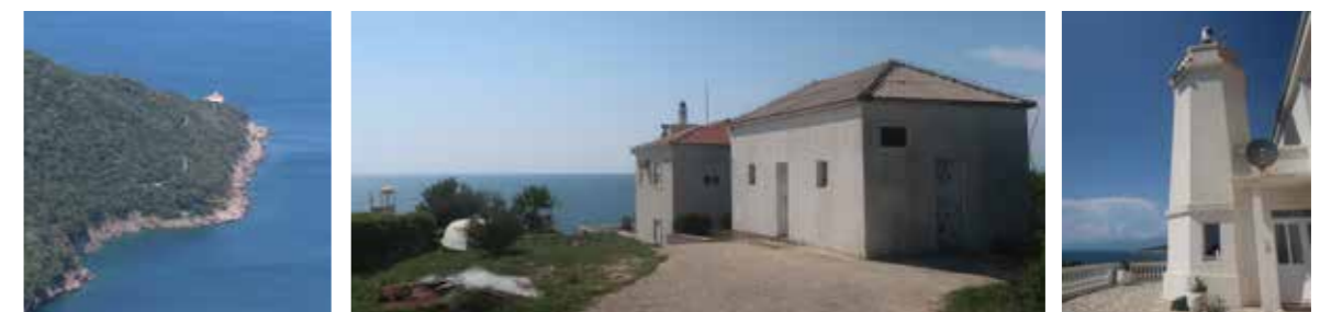
Fotografitë e fënerit, 2023.
