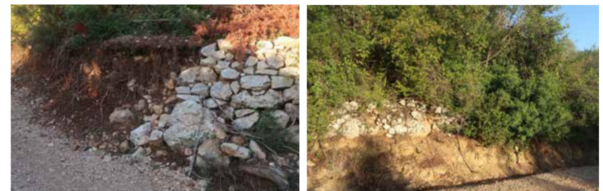
Pjesa e shembur e nënmurit dhe nënmuri që ka mbetur mbi segmentin e gërmuar të rrugës, rruga e zgjeruar drejt Kronit të Vakfit, 2023.
