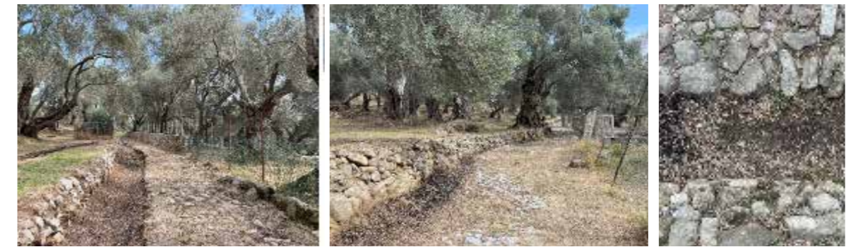
Fotografitë të shtigjeve me kalldrëm dhe kanal; detaj kalldrëmit dhe kanalit
