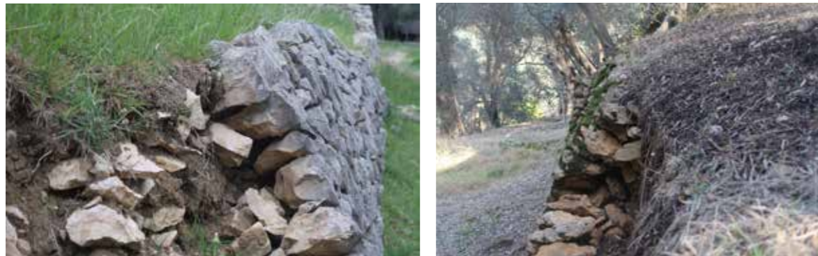
Podzidi terasa sa vidljivim licem i ispunom suvozida
