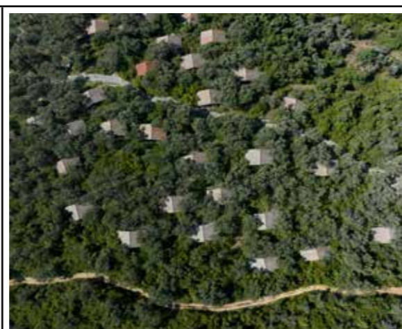
Dio odmarališta sa montažnim kućama za smještaj
