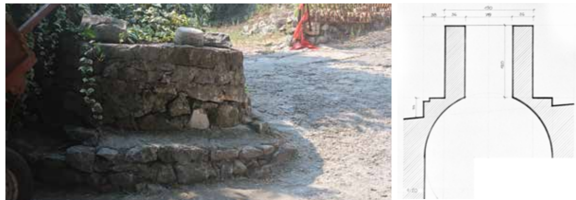
Fotografija i presjek kroz bunar
