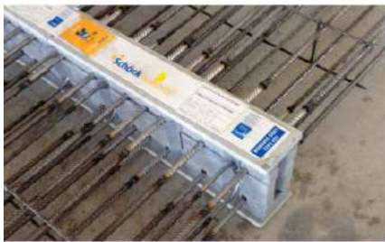
Slika 18: Pravilno prepoznate pozicije za postavljanje termoizolacije i primjer odličnog rješenja za konzolne ispuste
